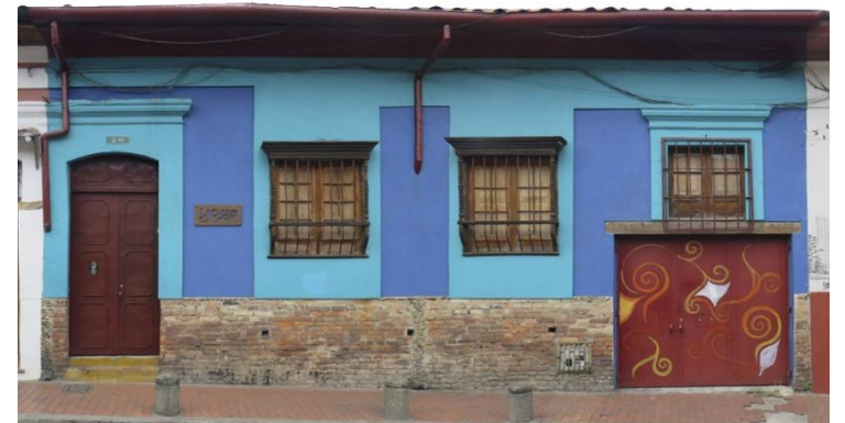
Fuente: Equipo Fotografía PEMP Patrimonio Inmueble
